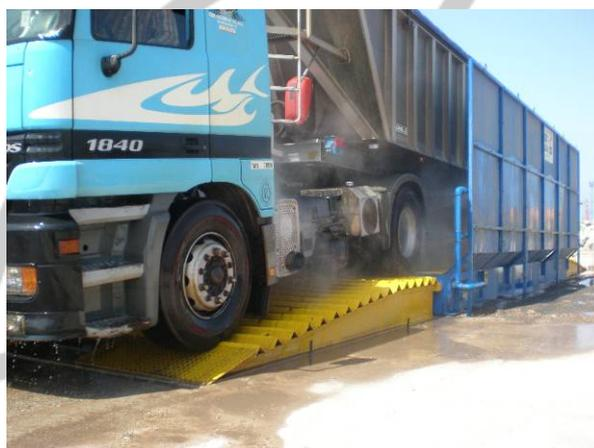
El modelo Powerwash reúne unas características óptimas para el lavado de ruedas en las condiciones mas extremas de suciedad. Capaz de soportar un tráfico de más de 800 camiones diarios, ya ha demostrado su eficacia en obras de gran envergadura, tales como la Ampliación del Puerto de Valencia o la Ampliación del Puerto de Gijón.
